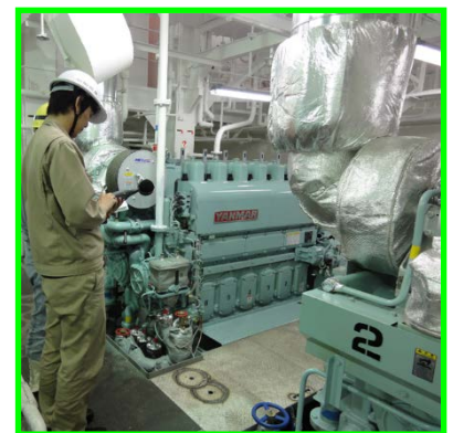
機関室内の騒音計測
